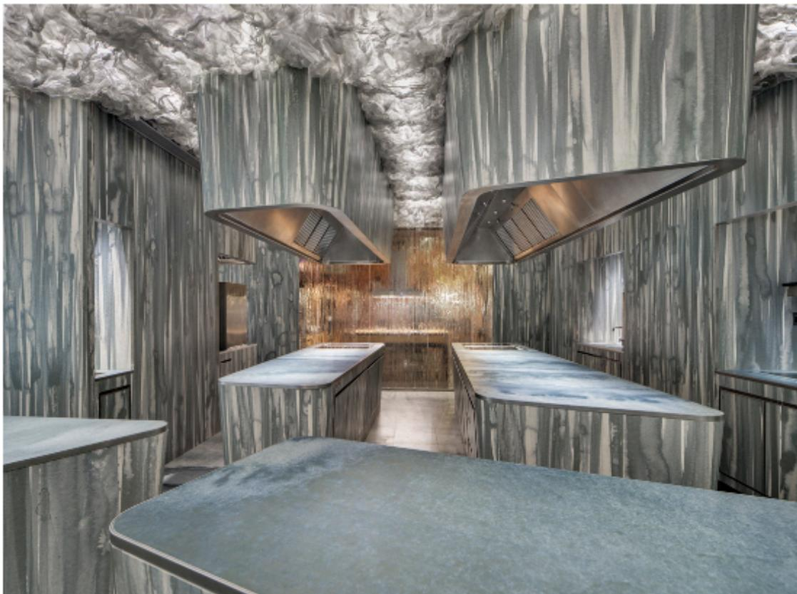
RCR dibujó su idea de diseño en acuarelas sobre papel y, en colaboración con Neolith, se creó una réplica exacta sobre la tabla de gran formato, que se aplicó en pavimento, paredes, baños, encimeras y campanas de cocina. Si bien este tipo de ejecución (desde el papel hasta la Piedra Sinterizada), nunca se había realizado antes, Neolith logró plasmar la idea de los arquitectos utilizando la tecnología de decoración de impresión digital, **Neolith Digital Design (NDD)**.
