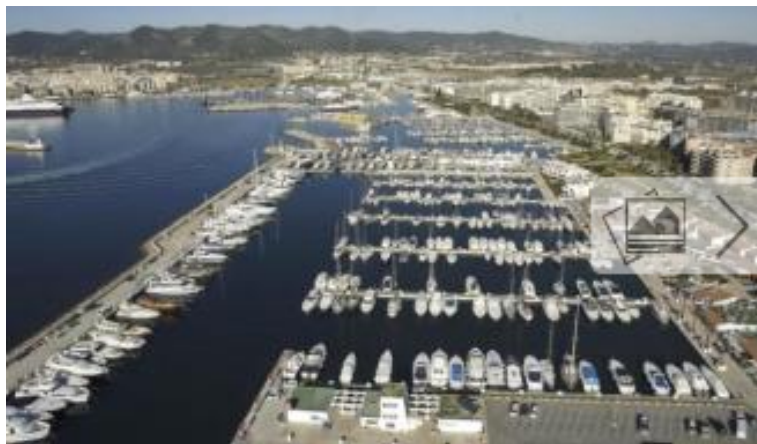
Vista panorámica del puerto deportivo Marina Botafoch. D.I.
